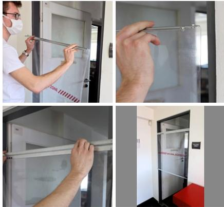
Schutztrennwand ET Flexi Paravent mit einer Konstruktion zur Befestigung an der Arbeitsplatte
