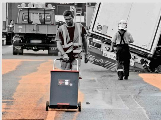
Gleichmäßiges Verteilen des Sorptionsmittels
