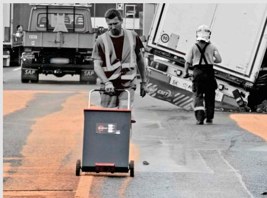
Gleichmäßiges Verteilen des Sorptionsmittels
