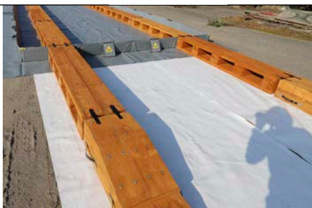
Záchytná vana s dřevěnými nájezdovými rampami
