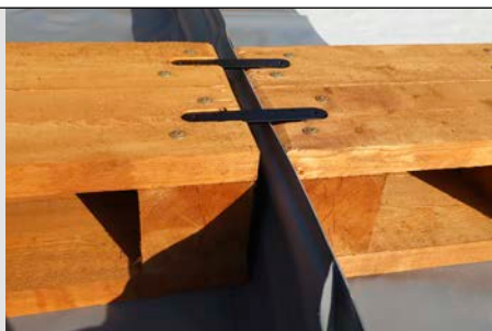
Detail ukotvení dřevěné rampy
