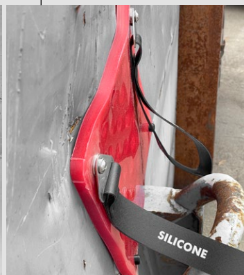
Záplata dokonale kopíruje nerovnosti povrchu poškozeného objektu
